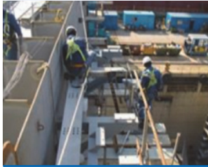
안전대부착설비 설치 및 안전대 착용
